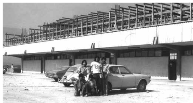
Construcción del segundo piso.
