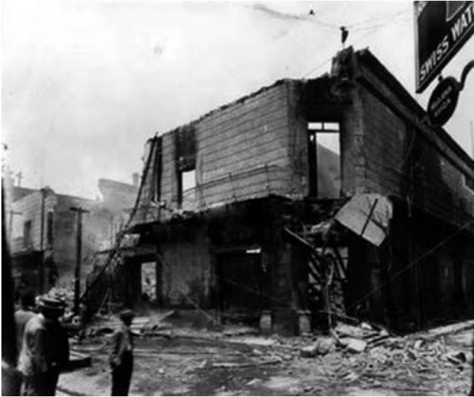
Los incendios fueron comunes en el proceso de industrialización.
