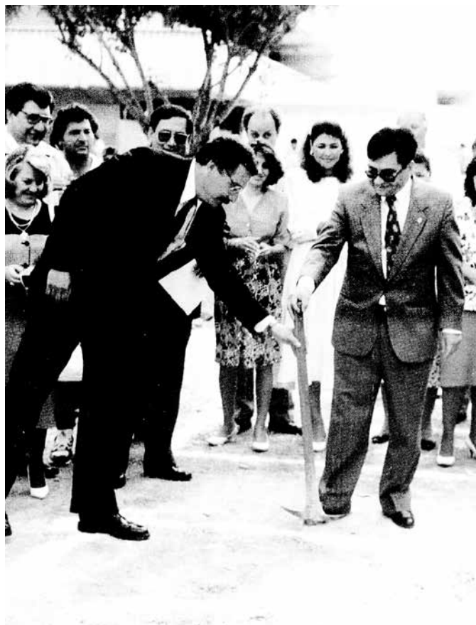
Autoridades universitarias en el inicio del actual edificio administrativo.
