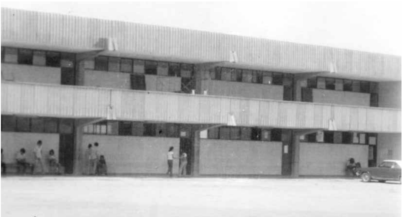
Vista general, ala sur.
